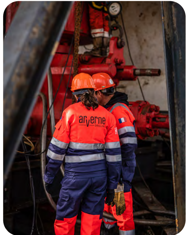
Forage de géothermie profonde
